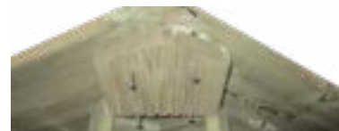
Fixing of the plates Fijación de los tacos bajo las placas Fixation de la plaque sous margelles Befestigung der Platten unter den Rändern Fissaggio delle piastre sotto i bordi Bevestiging van de platen onder de randen Fixação das placas sob os bordos
