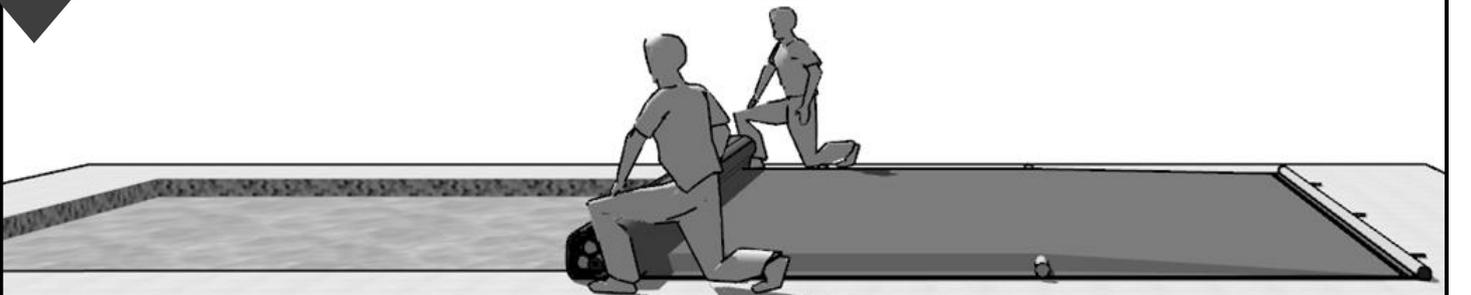
**3** Die Abdeckung ist entfaltet. Wir dehnen es sanft und positionieren es in Bezug auf den Beckenrand. Unter Berücksichtigung der seitlichen Überlappungen (Standard 20 cm pro Seite).
